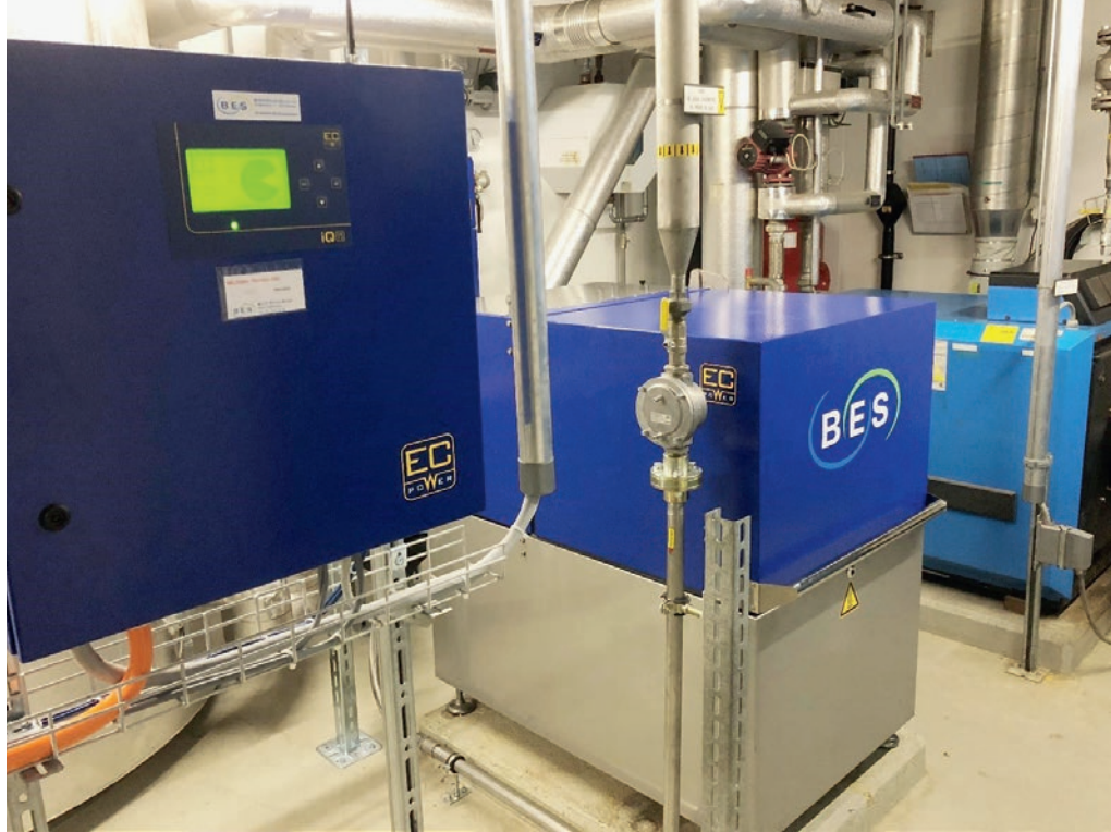
Il motor da gas ei vegnius montaus la fin 2018 ella serenera Raveras
