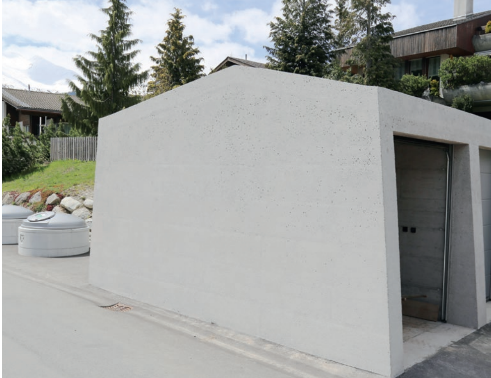
Niev baghetg d'infrastructura pil santeri e molocs
