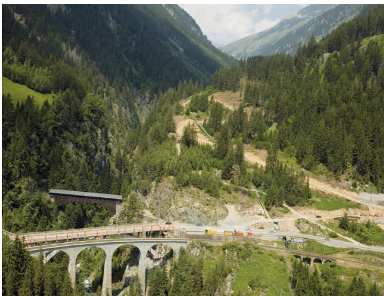
Punt Gronda cun via nova en Val Russein
