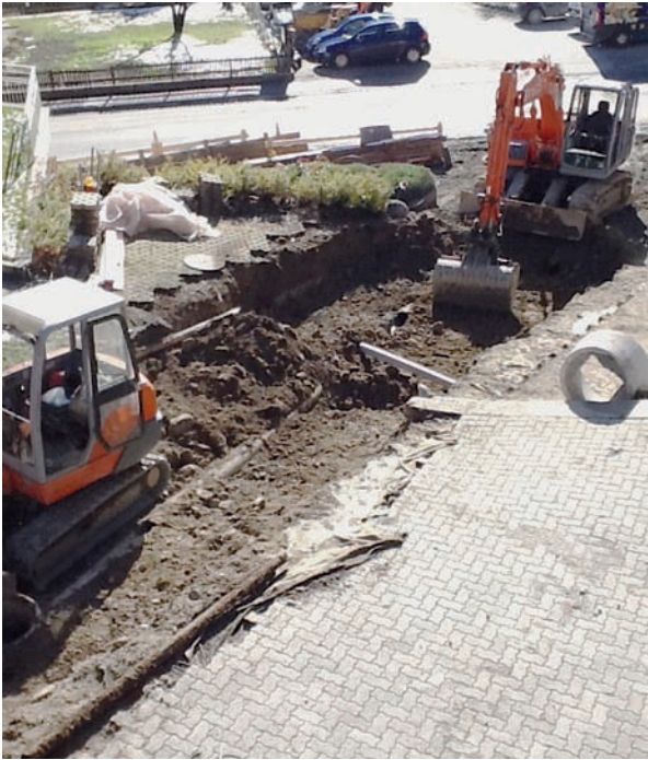
Sanaziun dalla Via Sogn Placi
