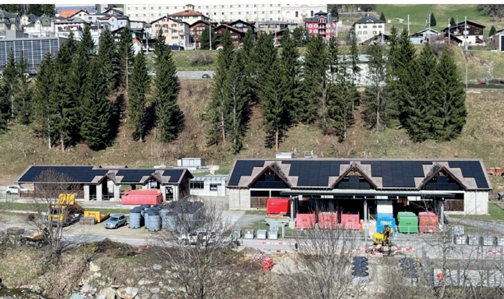
Igl atun ein ils stabiliments da fotovoltaic vegni montai sils tetgs e preits dalla serenera Raveras
