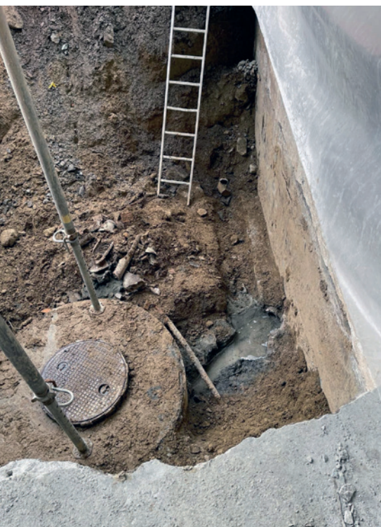
Lavurs da manteniment en connex cun la casa da scola, donns da canalisaziun
