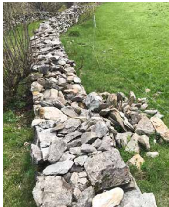
Mirs schetgs che sbalunan e spetgan da vegnir reparai
