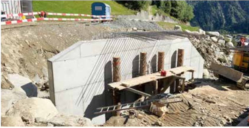
Fundament per la punt dalla Via Acletta Petschna nr. 32
