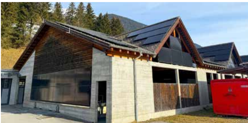
Ina part digl indrez fotovoltaic ch'ei dapi il fevrer en funcziun
