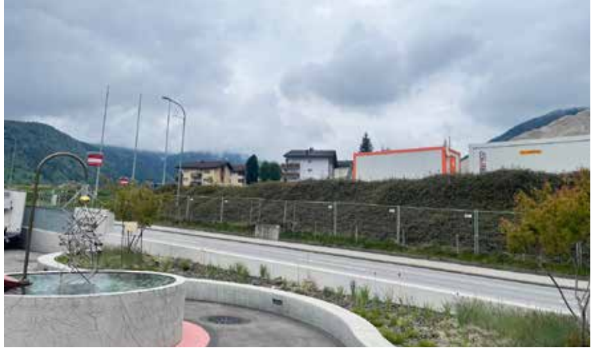
Il hotel Acla da Fontauna ei vegniu mess a tiara, las lavurs cuntinueschan
