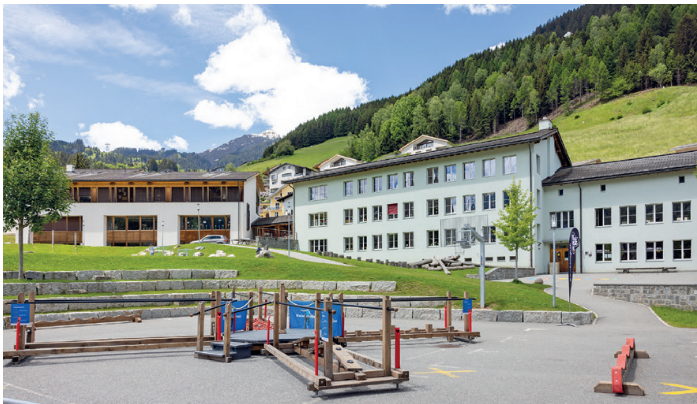
Areal da scola a Cons sco el se presenta actualmein.
