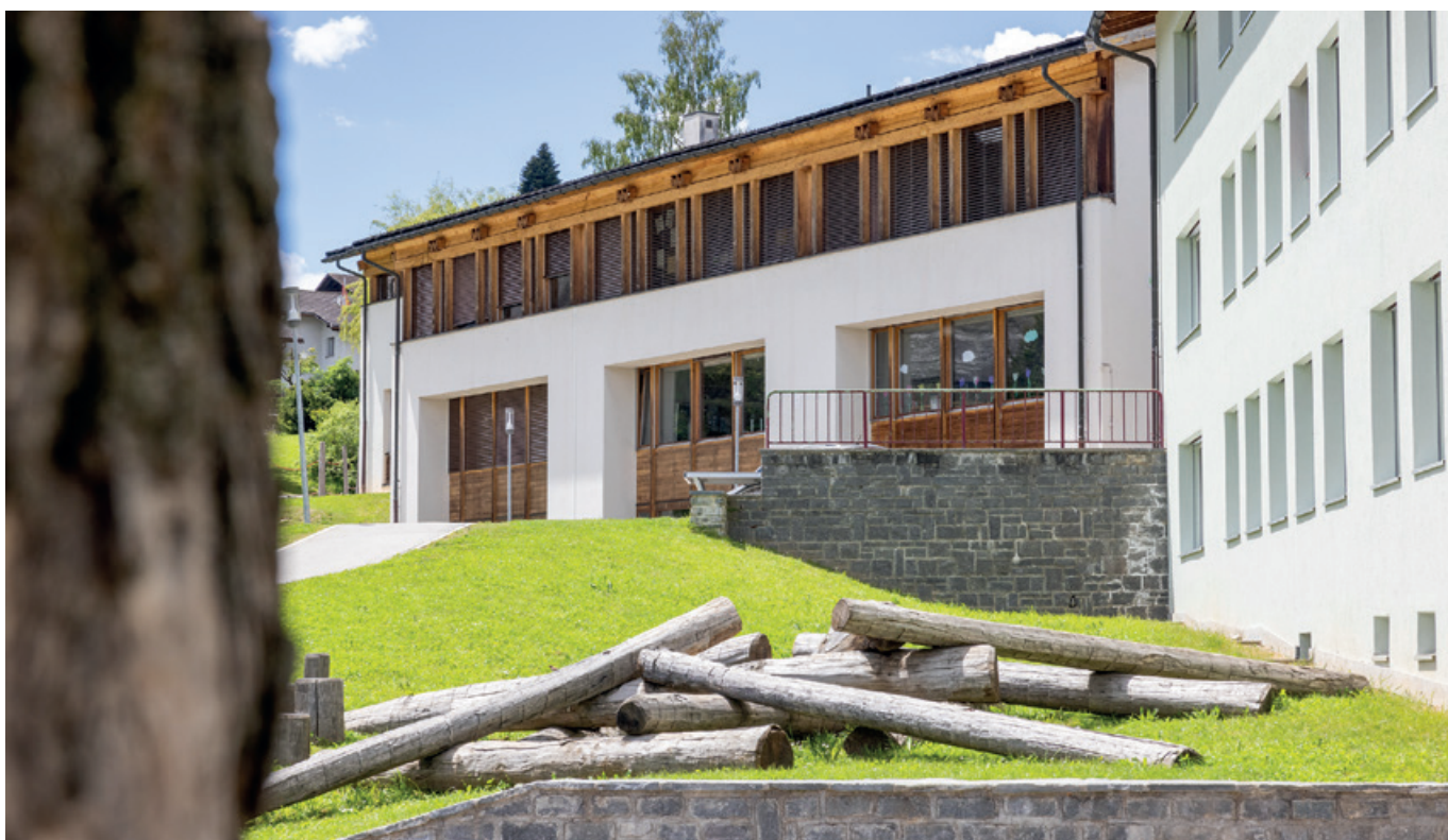
Il baghetg dalla scola populara a Cons ein en in stan different. La casa da scola veglia ha ina buna substantia, il baghetg erigius 1980 perencunter ei munglus. Fotos Vischnaunca Mustér
