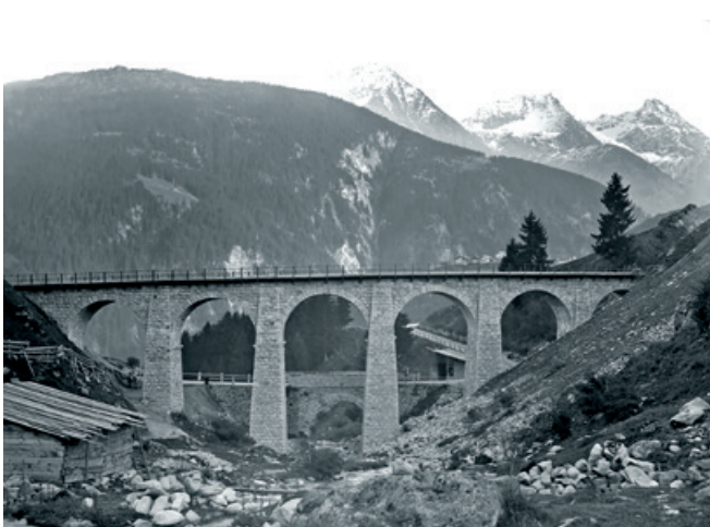
Il viaduct dalla Viafier Furca-Alpsu ella Val Segnas a Mustér. Foto Felix Huonder
